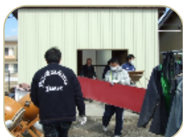
やまだ共生作業所 ～津波の被害を受けた 物品整理～
